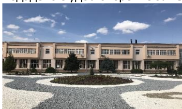
Основен корпус на ПГ след ремонта
