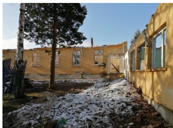
Център преди ремонта
